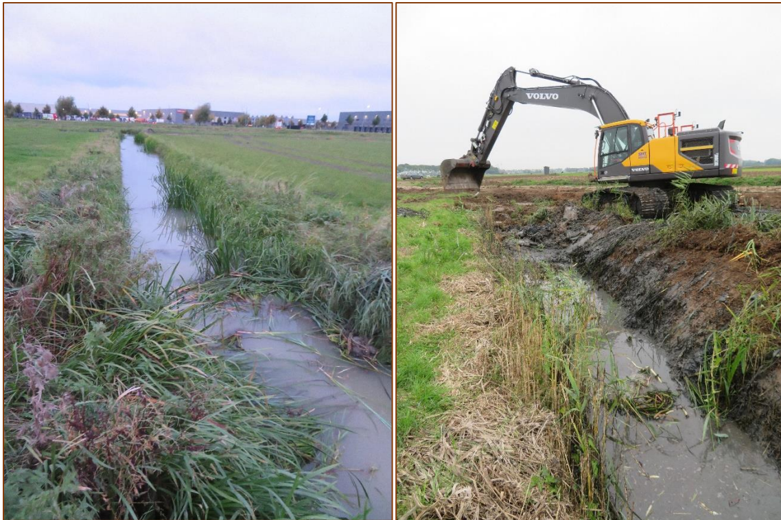
Foto's 1 en 2: enkele van de te dempen sloten (foto's: R. Top).
